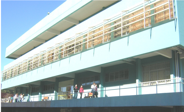
FIG. 39. Tomada externa do prédio da UNOESC que abriga o Curso de Odontologia.
